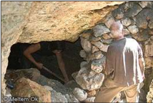
Construyendo la pared.
